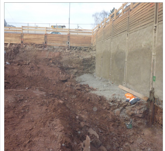
Bild 3: Baugrund u. Baugrubenverbau
