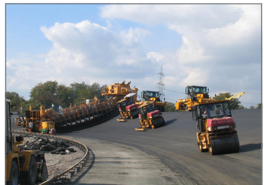
Bild 2: Brückenfertiger in der Steilkurve
